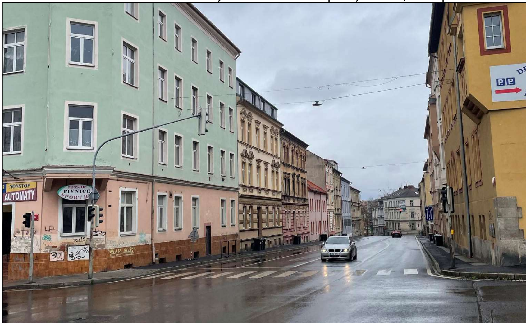
Obr. 7: Fotodokumentace zástavby v okolí kritického místa priority I v Chebu, ul. Evropská
