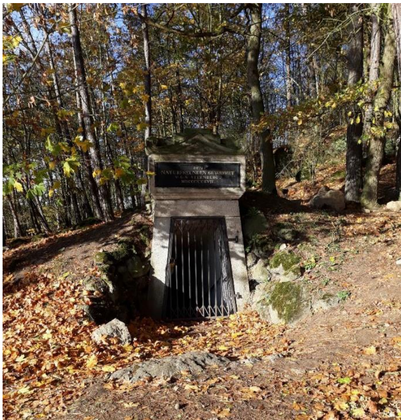
Komorní hůrka - zpřístupnění štoly
