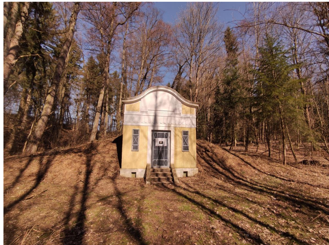
Zrekonstruovaná vodárna v Plané
